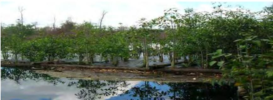
Gambar 3-28: Sekat karung pasir, bagian atasnya dibungkus geotekstil dan ditanami pepohonan (Sumber: Wardhana, B., 2016).
