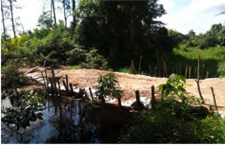
Gambar 3-16: Sekat urukan terbuat dari kayu, karung tanah, dan urukan di kanal berukuran sedang
