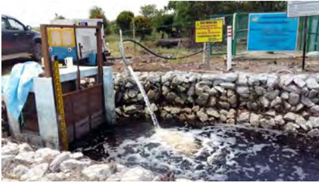
Gambar 3-22: Gabion dan pintu air dengan air yang bersumber dari sumur tabung di sekitar lahan (Catatan: Struktur gabion dengan batu-batu besar tidak cocok diterapkan karena air menerobos batu dan melewati pintu air)
