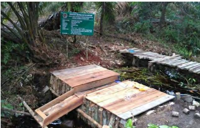
Gambar 3-19 (kiri): Sekat Kotak Kayu untuk kanal kecil (Sumber: Kementerian Lingkungan dan Kehutanan, Indonesia)
