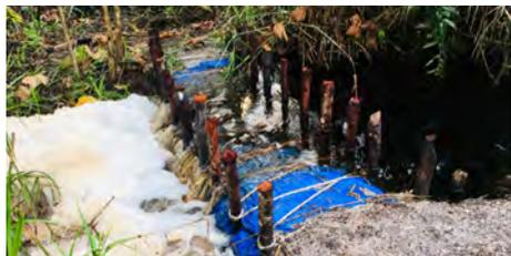
Gambar 3-24: Sekat karung pasir yang dibungkus terpal untuk mencegah erosi ketika air melewatinya
