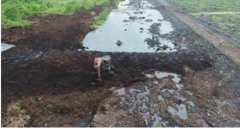
*Gambar: 3-12a (kiri): Lima rangkaian bendungan dari gambut yang dipadatkan dibangun di sepanjang kanal selebar 20+ meter di sisi barat Tahura OKI (zona penyangga di TN Berbak). Sekat ini dibangun saat musim hujan pada Jan-Feb 2018 dan berfungsi dengan baik setelah 1 tahun (Foto milik Mott MacDonald).*
