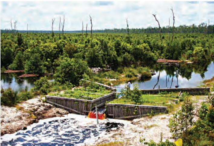
*Gambar 3-10: Bendungan yang dibangun sebagai penyekat kanal yang sebelumnya digunakan sebagai jalur transportasi kayu guna memulihkan tinggi muka air rawa gambut.*
