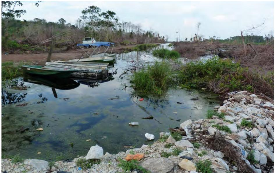
Gambar 3-18a: Bendungan dari pecahan batu di kanal besar pada akhir tahun 2012, 2 bulan pasca pembangunan.
