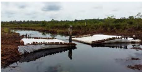
Gambar 3-23: Geotekstil yang membungkus sekat besar dan saluran pelimpah di bagian tengah untuk mencegah erosi.
