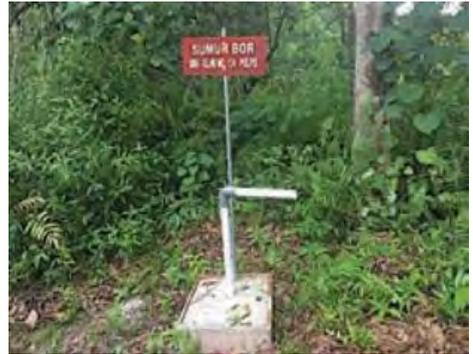
Gambar 3-40: Bor air tanah dibangun di lahan gambut rawan kebakaran yang ada di Indonesia.
