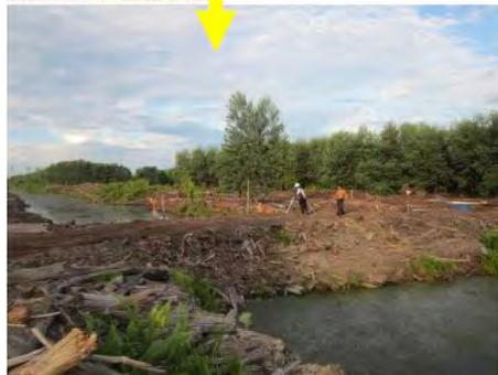
*Gambar 3-13: Kanal besar yang disekat dengan gambut yang dipadatkan (Sumber: Wardhana, B., 2016).*
