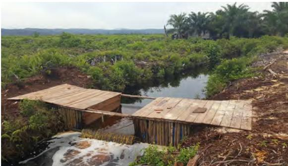
Gambar 3-26: Saluran pelimpah di tengah sekat kotak kayu untuk jalur lintas kapal kecil (Sumber: Kementerian Lingkungan dan Kehutanan, Indonesia) (Catatan: Rendahnya tingkat saluran pelimpah ini menunjukkan bahwa gambut di bagian hulu tidak dibasahi dengan sempurna)
