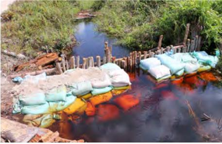
Gambar 3-14: Parit dengan lebar sedang yang disekat menggunakan karung pasir dan kayu.
