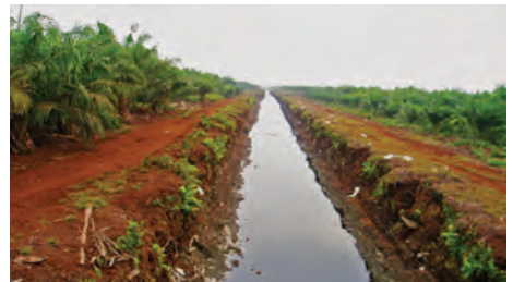
Gambar 3-8: Drainase yang berlebih pada saluran utama di area kubah gambut selama musim kemarau dapat menyebabkan tingginya emisi CO_2 , laju subsidiensi, meningkatnya risiko kebakaran yang tidak disengaja, serta menurunnya hasil panen yang signifikan.
