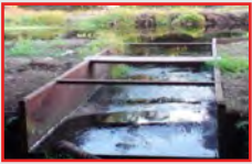
Gambar 3-19: Bagian terpenting dari penerapan sistem pengelolaan air adalah dibaginya perkebunan ke dalam berbagai zona pengelolaan air yang memiliki tinggi muka air yang relatif konstan di setiap zonanya. Gambar 3-19: Bagian terpenting dari penerapan sistem pengelolaan air adalah dibaginya perkebunan ke dalam berbagai zona pengelolaan air yang memiliki tinggi muka air yang relatif konstan di setiap zonanya.
