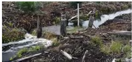
Gambar 3-4: Struktur kendali air tidak harus mahal dan dapat secara sederhana dibangun dengan kayu atau karung pasir.
