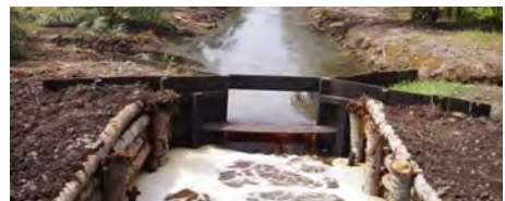
Gambar 3-5: Struktur lebih canggih (tapi masih berbiaya murah) pada saluran kolektor dapat dibangun dengan bendungan urugan dan papan kayu (contoh dari United Plantations, Malaysia).
