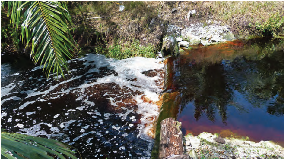
Gambar 7-4: Satu bendung dipasang di setiap titik penurunan muka air setinggi 20 cm untuk memungkinkan adanya retensi air di sepanjang saluran kolektor.
