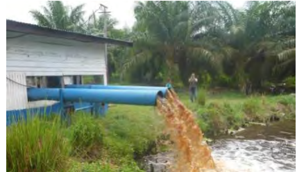
Gambar 3-10: Memompa air ke kanal untuk meningkatkan tinggi muka air selama musim kemarau.
