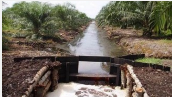
รูปที่ 4: โครงสร้างควบคุมระดับน้ำ
