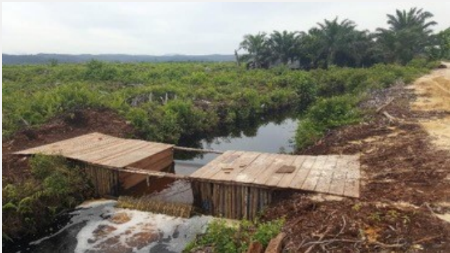
รูปที่ 4: โครงสร้างควบคุมระดับน้ำ
